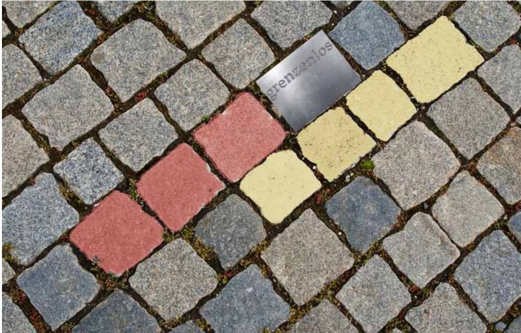
Einzelner Pflasterstein wird mit einer rohen Edelstahlplatte ersetzt mit eingraviertem Text. zBsp.:
